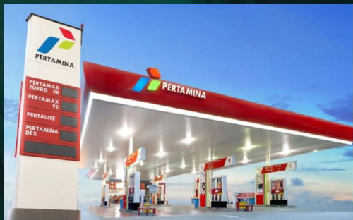
Fasilitas Sekitar Lengkap
